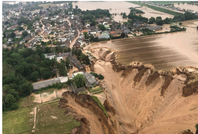
Hochwasser in Deutschland 2021 ©RHEIN-ERFT-KREIS
